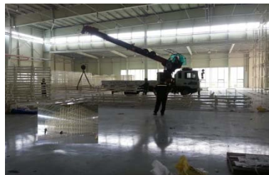
Unit Rack 설치
